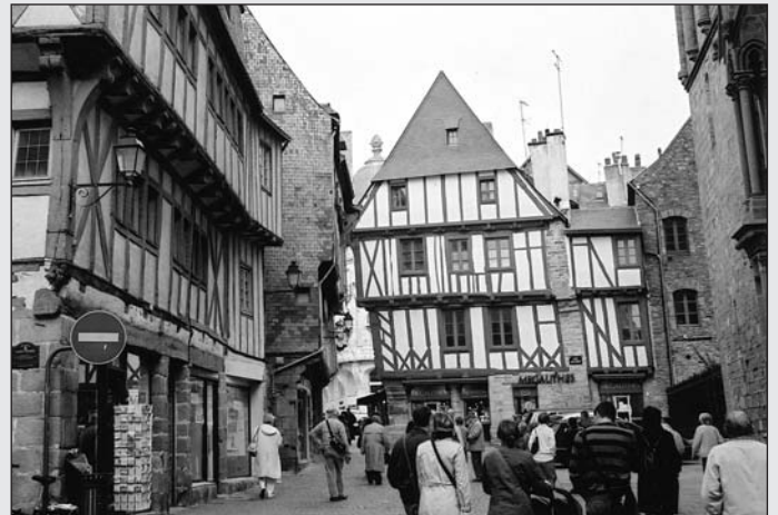
Photo 11. Vannes : Maisons à colombages (Coll. M. DUBOS)
