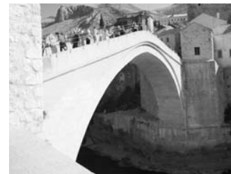
Photo 7 : Le pont de Mostar (Coll. P. DUC-GOIRAN)
